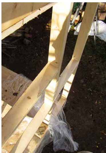
Huset är byggt i en stående regelkonstruktion. Bilden är tagen uppför och man ser det övre golvet som besökaren går på och den nedre där tunnan och tanken ska stå.
