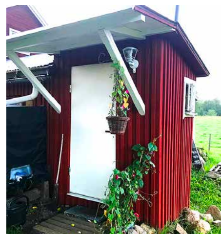
Efter några regniga höstar kompletterades dasset med ett rejält takutsprång.
