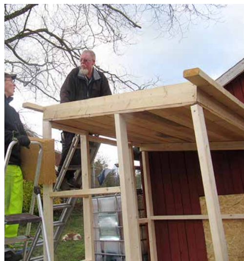
Taket byggdes på marken och hävdes upp. Till vänster min man Ingvar och till höger vår vän Johan som hjälpt oss med så många byggprojekt.
