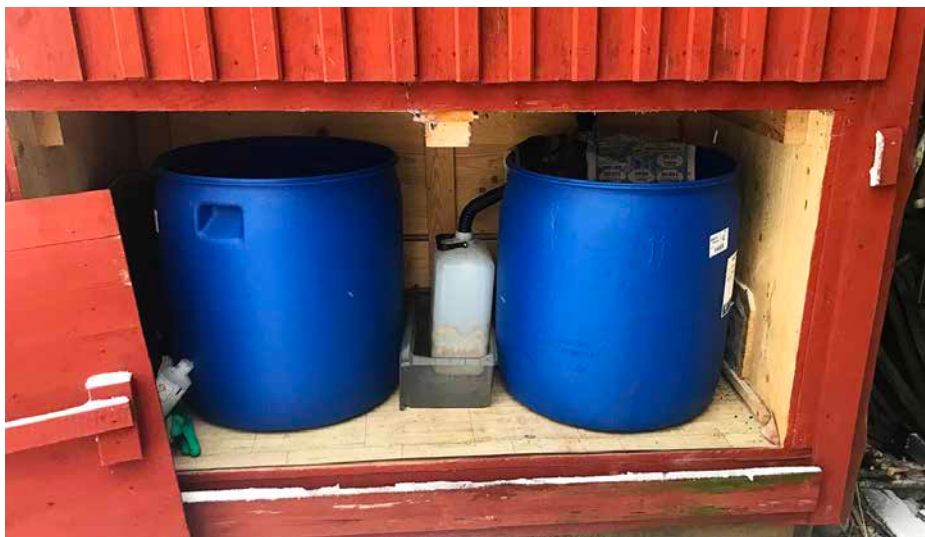
Baksidan med plats för tunnor och dunk. Luckan kan lyftas av. Urindunken står för säkerhets skull i en plastbalja och golvet är klätt med en uppvikt plastmatta.
