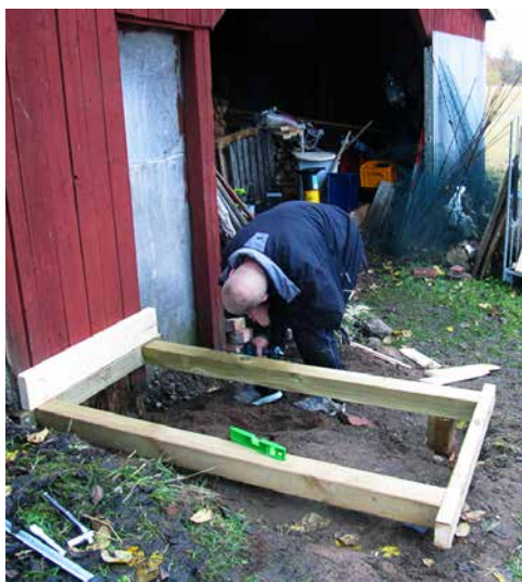
Vi hittade en sluttning där dasset kunde anslutas till ett befintligt uthus. Efter mätning och lite grävning lades en ram ut och fästes i ena änden i en grov regel i uthuset.
