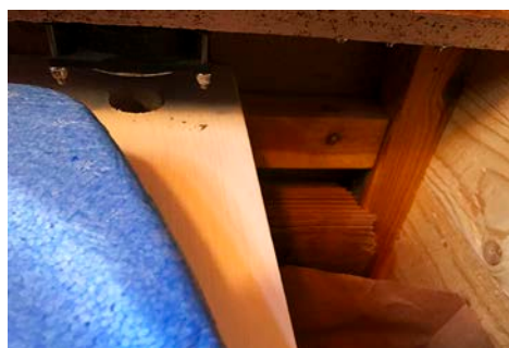
Fläkten bör placeras vid sidan om sittbrädan. I vårt fall var det inte möjligt men ett rejält hål i sittbrädan löste problemet.
