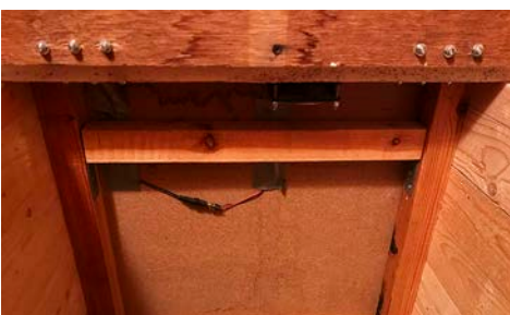
Lådans bakvägg med hörnstolpar, horisontell regel som sittbrädan ska vila på och fläkten monterad.
