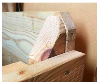
Den lägre fronten binds ihop med den högre sidan genom en snedkapad hörnstolpe.
