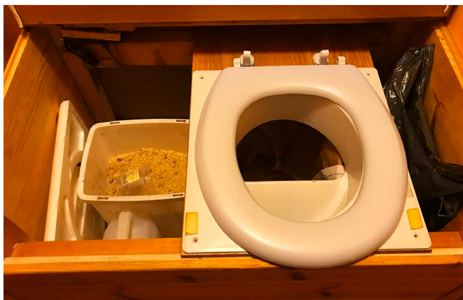
Lådtoaletten hemma i gäststugan är 84 cm bred vilket medger plats för soppåse och ströhink på vardera sida. Obs! Bilden visar insatsen "Dass-Isak" som var föregångaren till Separett Torrdass 500 som beskrivningen utgår ifrån.
