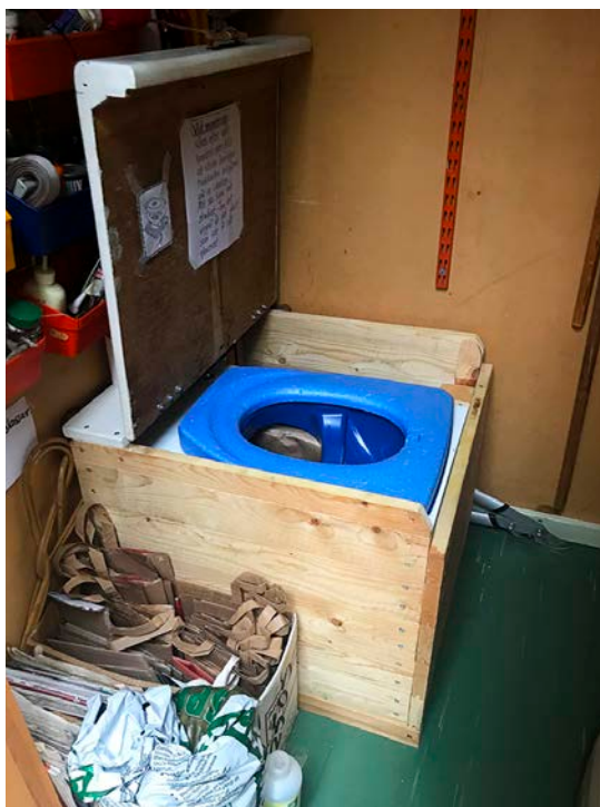
Lådtoaletten i fjällstugan står i ett trångt utrymme och är bara 60 cm bred med utrymme till höger om sitsen (sett framifrån) för att komma åt att byta dunken. På bilden syns också det lilla glidskyddet som håller sittbrädan på plats.
