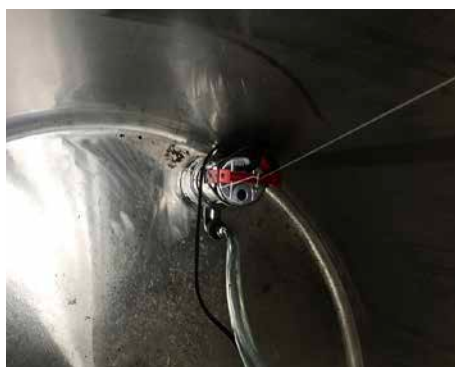
Pumpen är placerad på botten av tanken. Flottören fästes mot pumpens sida med buntband och en spänd nylonlina ska förhindra att pumpen välter.
