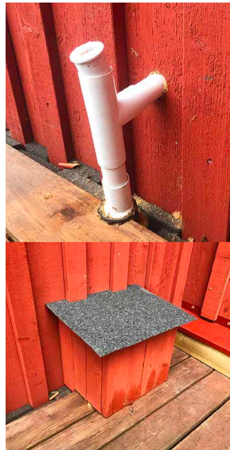
Nu är röret isolerat med cellglas och verandan återställd. På bilden syns locket som kan öppnas för rengöring och inspektion. En isolerad låda skyddar utloppet.
