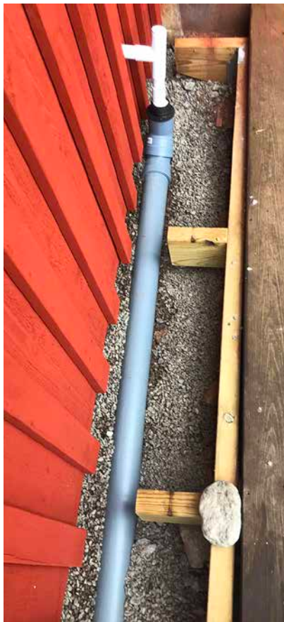
Det medföljande 32 mm-röret kommer ut ur husväggen med en svag lutning. Vi har placerat en öppningsbar koppling för inspektion och rengöring innan det växlar upp till ett grövre rör.
