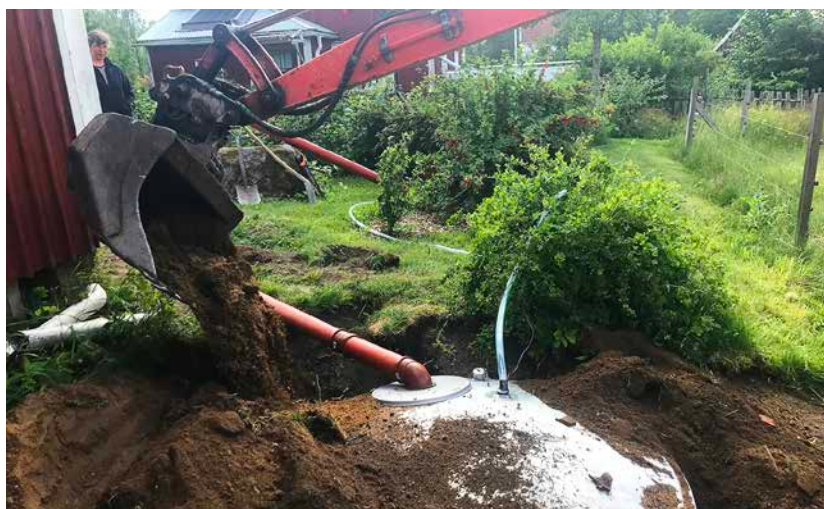
Tanken grävs ner. En smidig grävmaskin och en multikompetent förare underlättade arbetet enormt.
