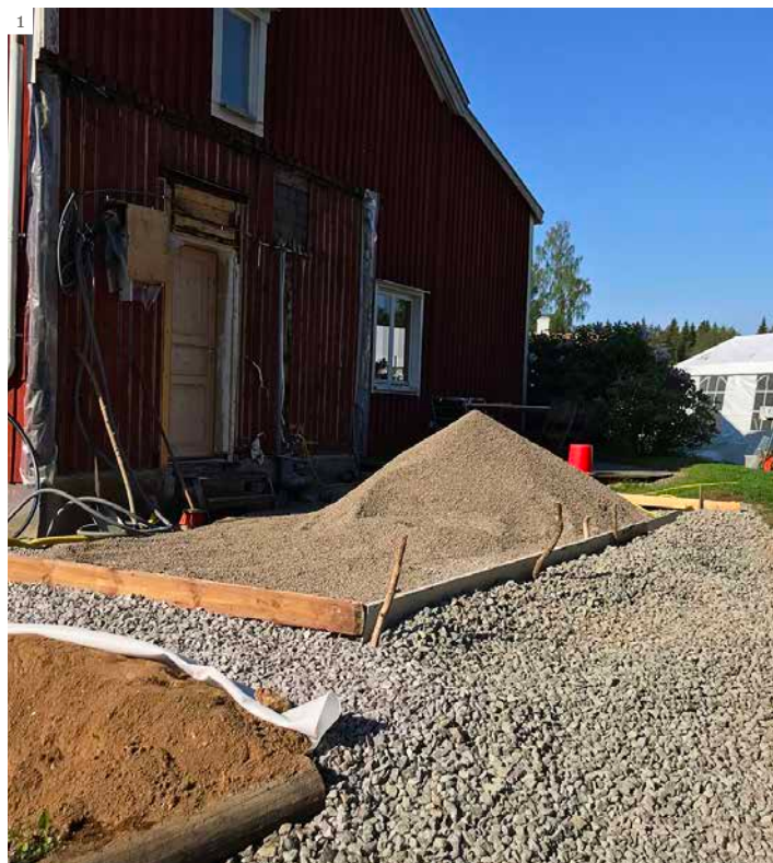
1. Utbyggnad påbörjad, underlaget till cellglaset i en hög. 2. Ritning Cellglas: a. undergrund av makadam (16–32), bärlager makadam (4–8); b. första lagret cellglas; c. makadam (4–8) som kantmaterial, 30–50 cm bredd; d. andra och tredje lagret cellglas (observera vot); e. puts eller putsskiva; f–g. jord med växtlighet eller grus med stenplattor. Väggen har inte byggts som på bilden utan så som beskrivs i texten. 3. Cellglaset.
