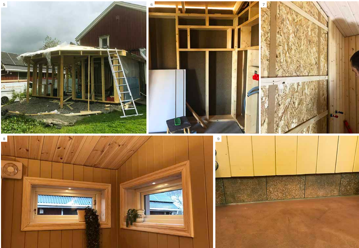
5. Regelkonstruktionen. 6. De vindtäta skivorna monterade på utsidan. Dags för isolering och OSB-skiva på insidan. 7. Luftspalt bakom panelen skapas med hjälp av skruvläkt på masonitremsa. 8. Luftspalt mellan panel och tak. 9. Fuktskyddad anslutning mellan golv och vägg. Luftspalt bakom panelen.
