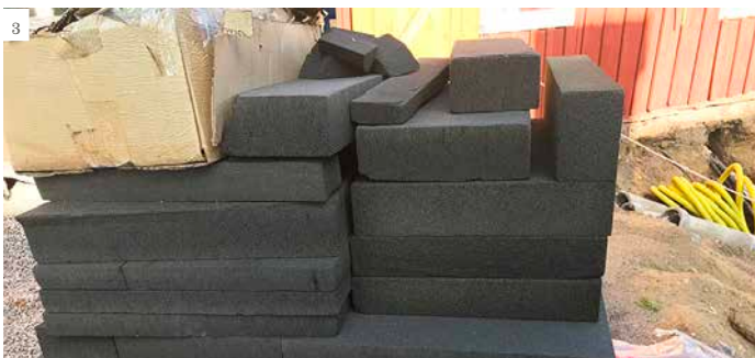
1. Utbyggnad påbörjad, underlaget till cellglaset i en hög. 2. Ritning Cellglas: a. undergrund av makadam (16–32), bärlager makadam (4–8); b. första lagret cellglas; c. makadam (4–8) som kantmaterial, 30–50 cm bredd; d. andra och tredje lagret cellglas (observera vot); e. puts eller putsskiva; f–g. jord med växtlighet eller grus med stenplattor. Väggen har inte byggts som på bilden utan så som beskrivs i texten. 3. Cellglaset.
