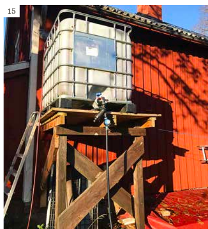
15. Ett av vattentornen hos Hillevi. Härifrån har systemet testkörts för enbart kålskiftet (ca 20–30 meter bort) under 2022. 2023 kommer denna tank bara fungera som mellanlager av regnvatten och en annan matartank. Istället närmare odlingarna på en stapel av lastpallar. Matartanken fylls från tanken på bilden genom slang med hjälp av höjdskillnaden. 16. Överskottsvatten leds i en slang till tunnor i grönsakslandet. Tunnorna används för att vattna med kanna. Slangen är bara intryckt i ett lagom stort hål, vilket håller tätt.
