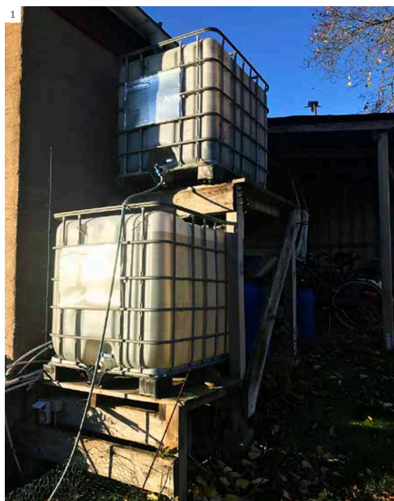
1. Regnvattnet samlas i upphöjda tankar under hängrännen för att bevara den användbara lägesenergin. 1 meter motsvarar 0,1 bar. 2. Droppbevattning i källandet. Grönsakslandet standardiseras i "moduler" där storleken bestäms av det nyinförskaffade källnätet. Då kan också alla droppslangar vara lika långa, vilket underlättar hanteringen.
