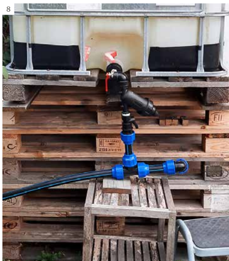
7–8. Det är inte helt enkelt att veta hur filtret ska kopplas till tanken. Ingen bruksanvisning medföljer till adaptorn som är avgörande för monteringen. Carola och Hillevi löste det på lite olika sätt och båda fungerar. 7. Hillevis kopplingar, kompletterad med timer från Biltema. 8. Carolas kopplingar. Foto: Carola Kjellgren.
