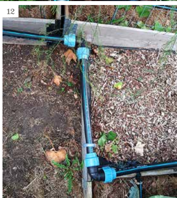
9. På friland används PEM som matarslangar. För att förbinda droppslangarna till dessa behövs särskilda anslutningskopplingar som trycks in i matarslangen i ett 5 mm borrhål (som först värms med värmepistol). Sedan skruvas droppslangen fast i andra änden av anslutningskopplingen. 10. T-kopplingar till matarslangen möjliggör flexibelt byggande. 11. Ett prydligt sätt att fästa matarslangen i odlingsramar hos Carola. Här ser man också hur droppslangarna fäster in i matarslangen och en blå ändstopp på matarslangen. 12. Böjar på 90 grader möjliggör flexibelt byggande av matarslangen. Även 45 graders böjar och kulventiler (avstängning) finns att köpa. Foton: Carola Kjellgren.
