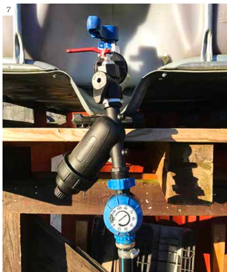
7–8. Det är inte helt enkelt att veta hur filtret ska kopplas till tanken. Ingen bruksanvisning medföljer till adaptorn som är avgörande för monteringen. Carola och Hillevi löste det på lite olika sätt och båda fungerar. 7. Hillevis kopplingar, kompletterad med timer från Biltema. 8. Carolas kopplingar. Foto: Carola Kjellgren.
